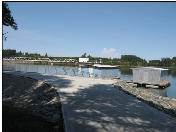
Zpevněná nástupní plocha přístaviště
