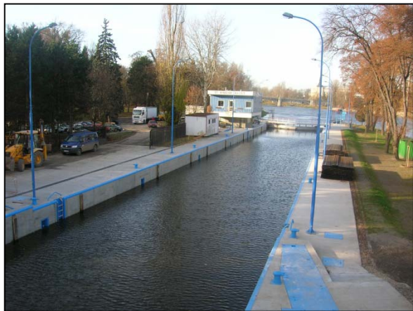
Prefabrikované líce zdí plavební komory
