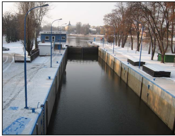
Nové plato plavební komory s úvaznými prvky
