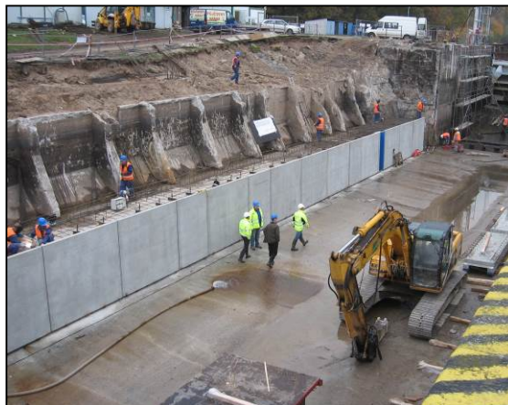
Výstavba nové zdi plavební komory
